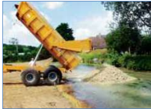
Exemples de principe de recharge en granulats par banquette.
