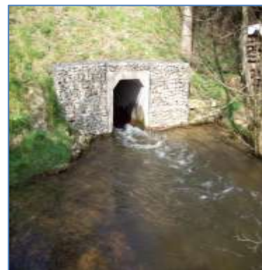
Exemples de réalisation de pont cadre sur le Sarthon (61).
