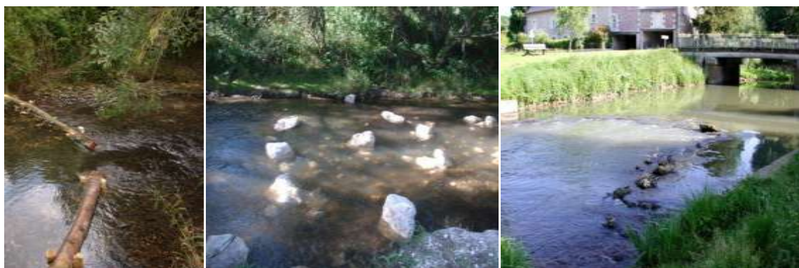
Exemples de travaux réalisés sur la Brenne (37) – Photos : F. Languille : déflecteurs en bois, dispersion de blocs sur un radier, création d'un mini-seuil
