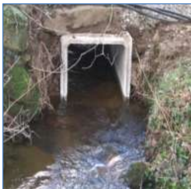
Exemples de réalisation de pont cadre sur le Sarthon (61).
